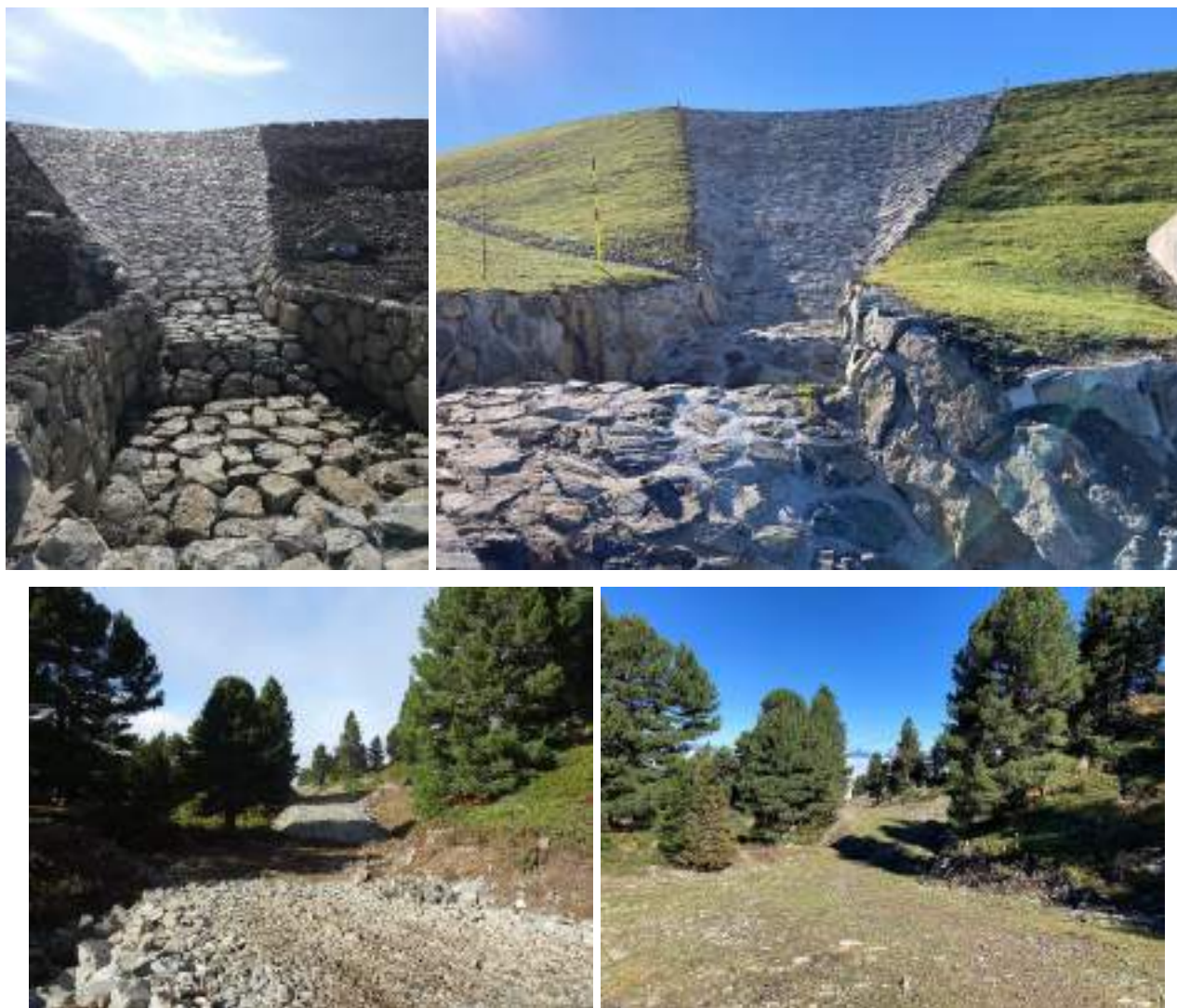
AVANT / APRES – RETENUE DE ROCHE BERANGER
