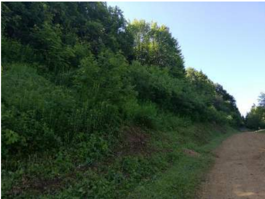
TALUS EN BORDURE DU CHEMIN 4X4, FAUCHE SUR LA PARTIE BASSE
