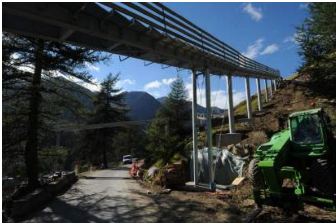
EXEMPLES DE PASSERELLE SUR ROUTE : LUGE VERDON EXPRESS A ALLOS (04)
