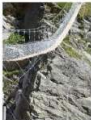
CÂBLE AU VENT
