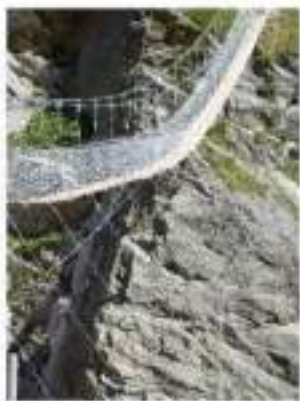
CÂBLE AU VENT
