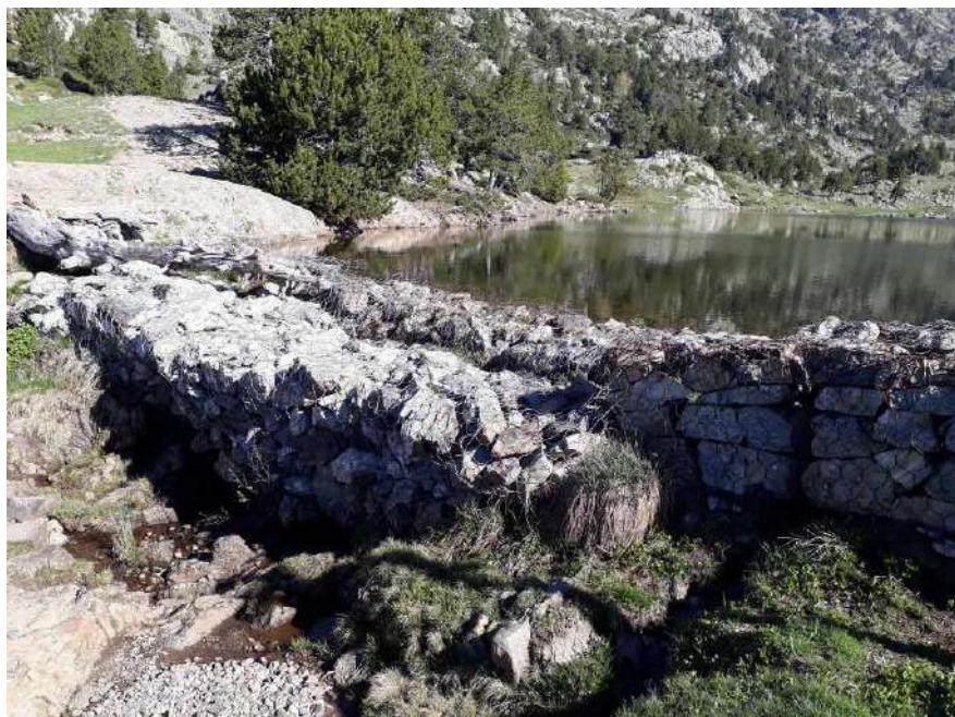
Photo 5 : le gabion en aval du lac Achard
