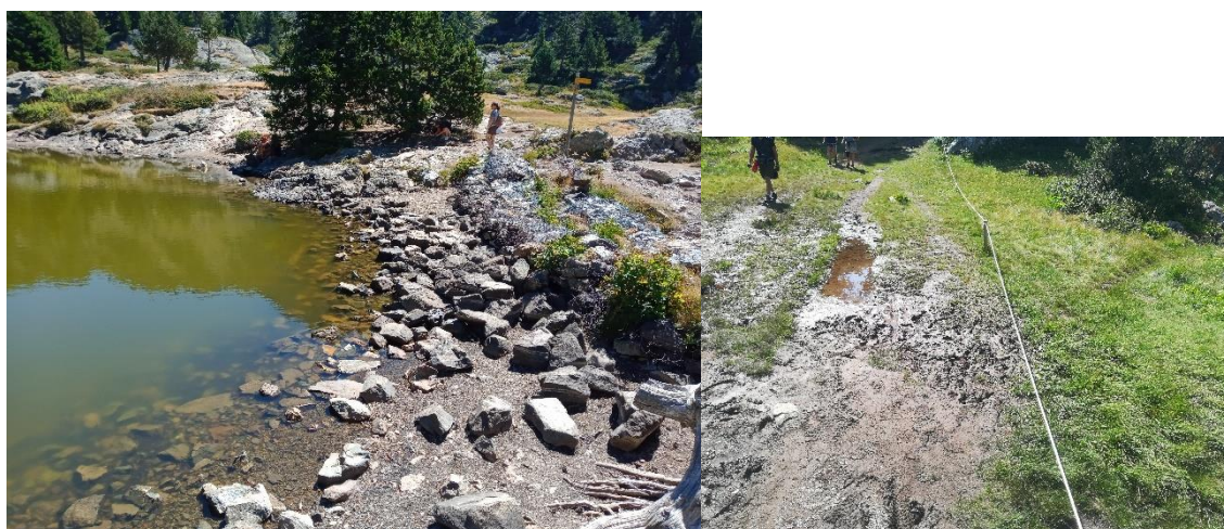
Altération chemin principal (secteur ACH3)
