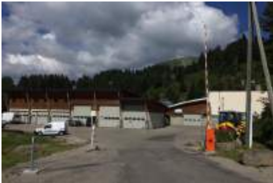
Accès à la plateforme techniques depuis la rue des Brokentins
